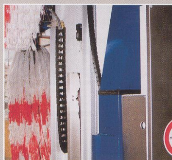
Impianto autolavaggio. Installazione di catena portacavi
